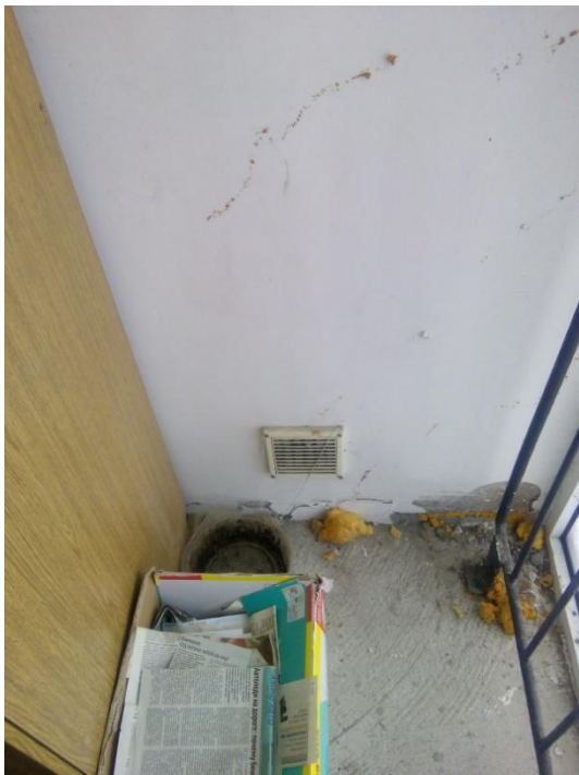
г. Казань, ул. Актайская, д. 47 (протекания застекленных балконов через стыки бетонных плит)
