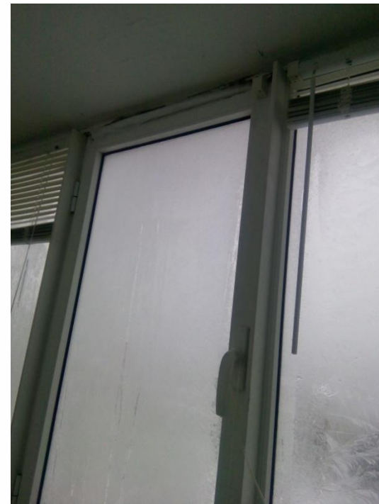
г. Казань, ул. Актайская, д. 47 (протекания застекленных балконов через стыки бетонных плит)
